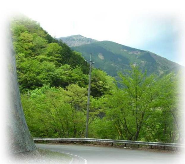
神ノ川林道より大室山の山崩れを見る
