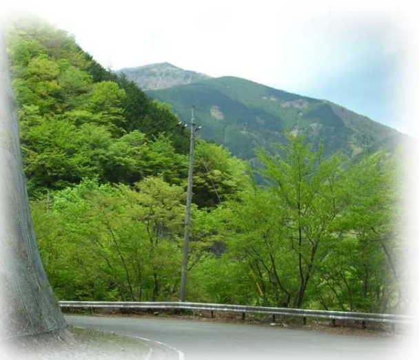
神ノ川林道より大室山の山崩れを見る
