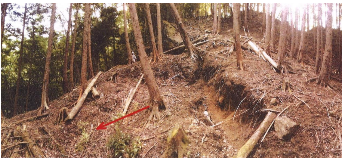
神ノ川林道上側山頂部の亀裂の様子
