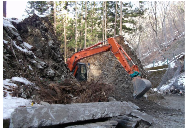
和田林道 山崩れ工事の様子
